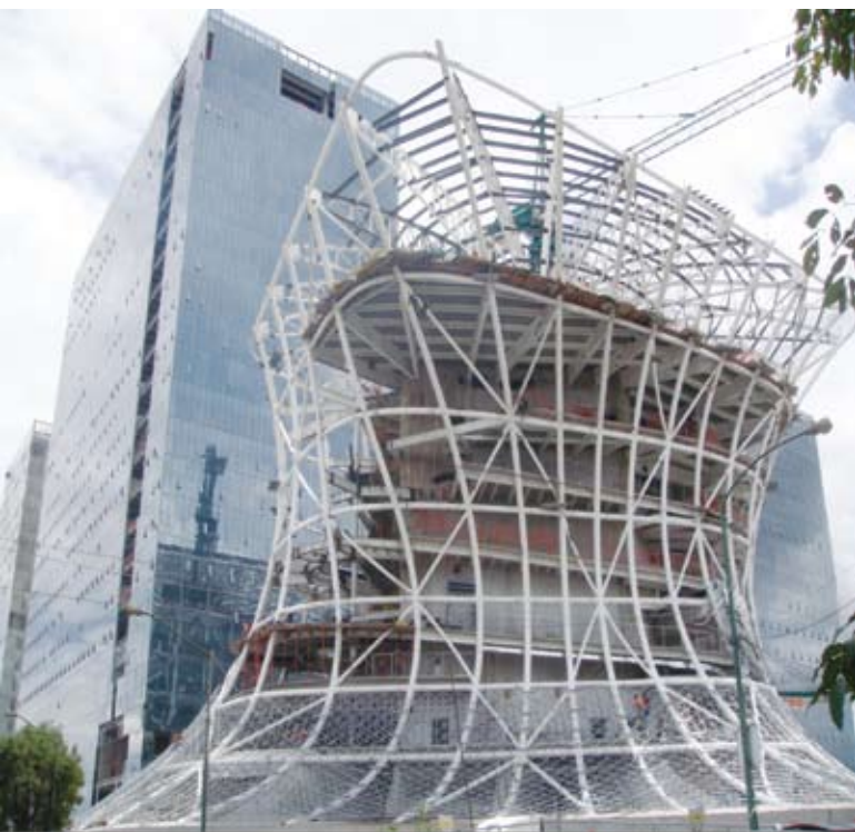
Estructura portante del Museo.
