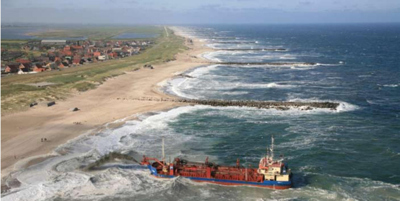
Figura 6: Regeneración de playas en campo de espigones
