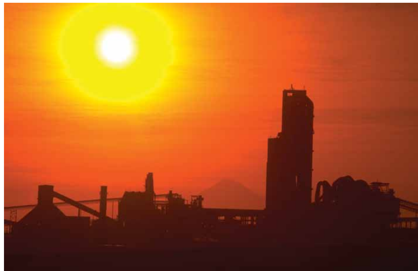
Planta de cemento de CEMEX en Tepeaca, Puebla, México.
