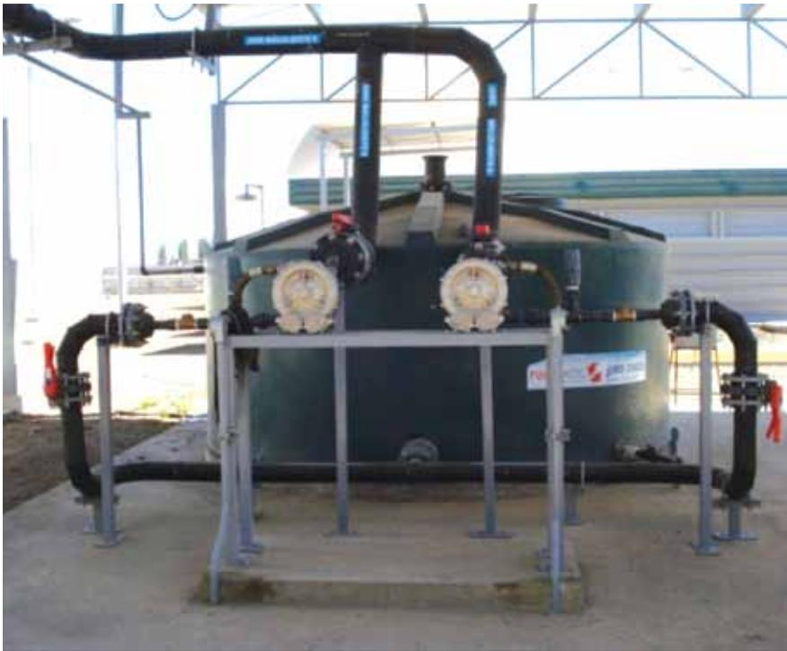
Figura 2. Biofiltro para la eliminación de olores en una planta de tratamiento de agua residual (Desarrollo IBTECH®)
