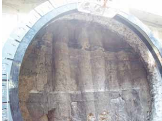
Figura 6. Vista del terreno mejorado
