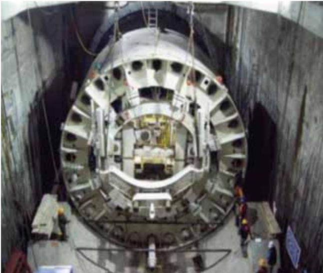
Figura 5. Proceso de ensamble de la tuneladora
