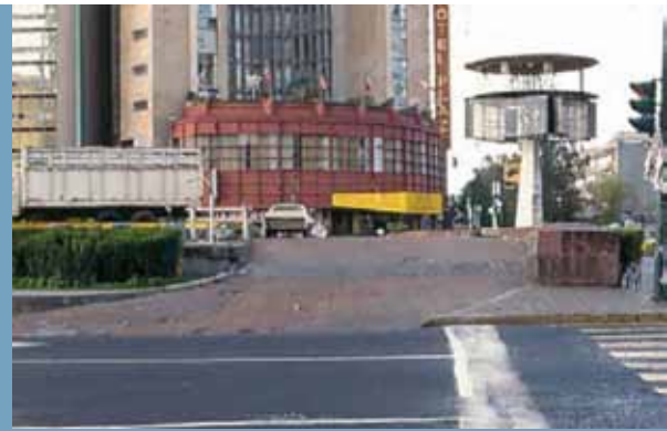
Emersión aparente de un estacionamiento subterráneo en la zona lacustre del valle de México (Auvinet et al.)
