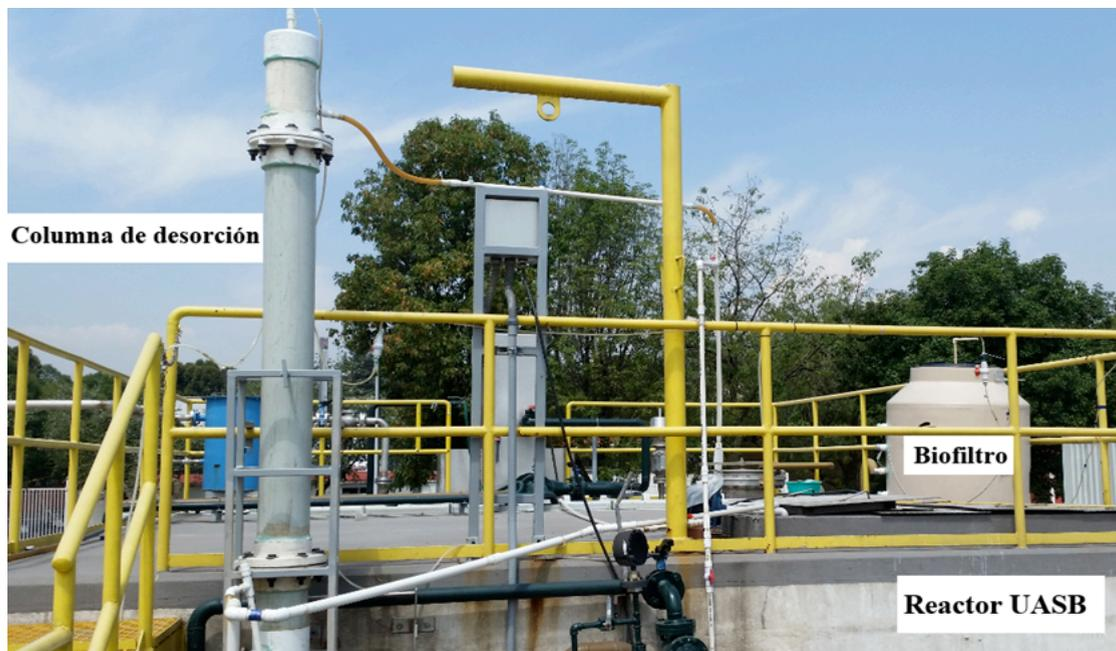
Figura 2. Planta piloto para el control de las emisiones de  $\text{CH}_4$  y  $\text{H}_2\text{S}$  disueltos en el efluente anaerobio. Instalación ubicada en la FES Acatlán (Huete *et al*, 2016)
