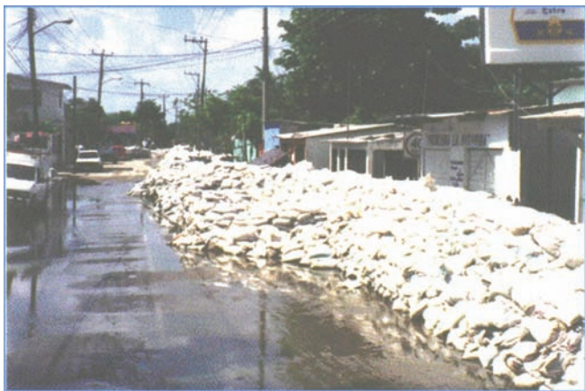
Fig 1 Bordo de costales para restringir la zona de inundación en Villahermosa, Tab
