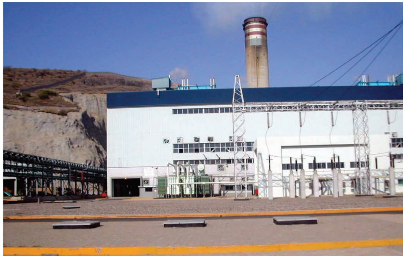
Fotografía del edificio donde se encuentran las unidades 1 y 2 de la Central Termoeléctrica (Topolobampo II)
