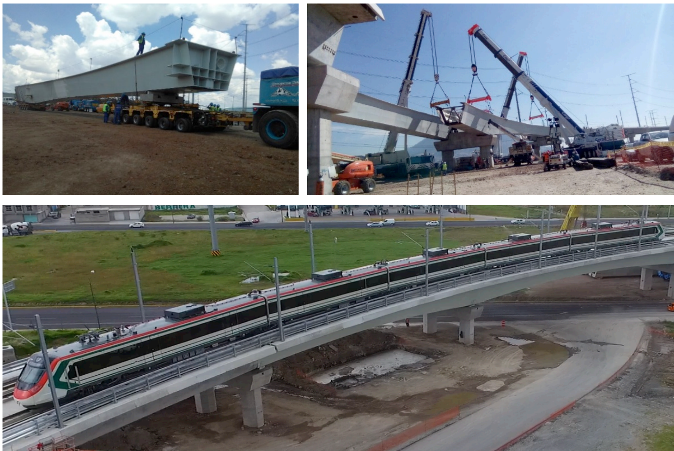
Figura 2. Viaducto 6, Tren Interurbano México-Toluca
