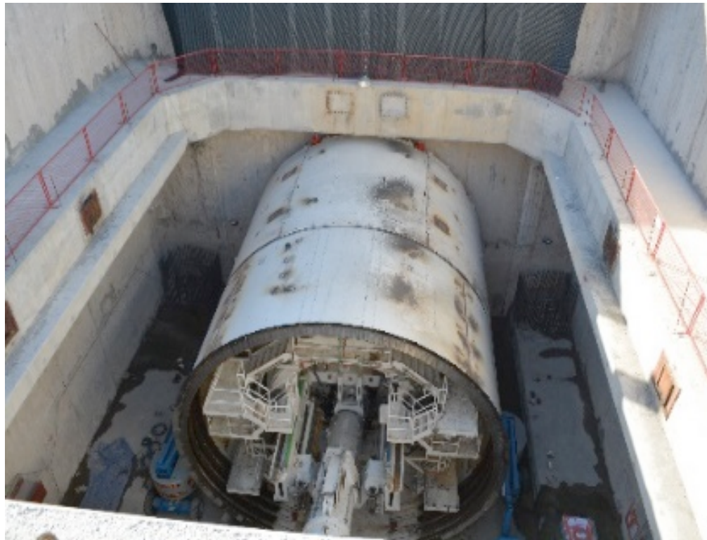
Figura 2. Escudo de la tuneladora. Instrumentación automatizada utilizada para el monitoreo del desempeño de la Catedral durante la obra
