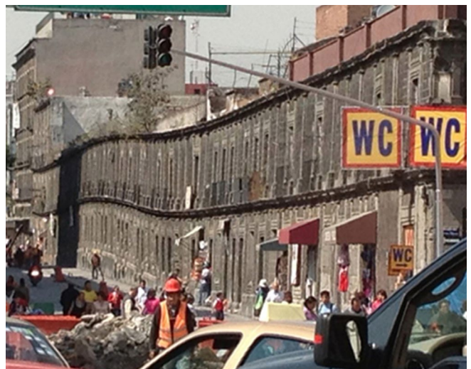
Infraestructura urbana afectada por la sobreexplotación del acuífero del valle de México
