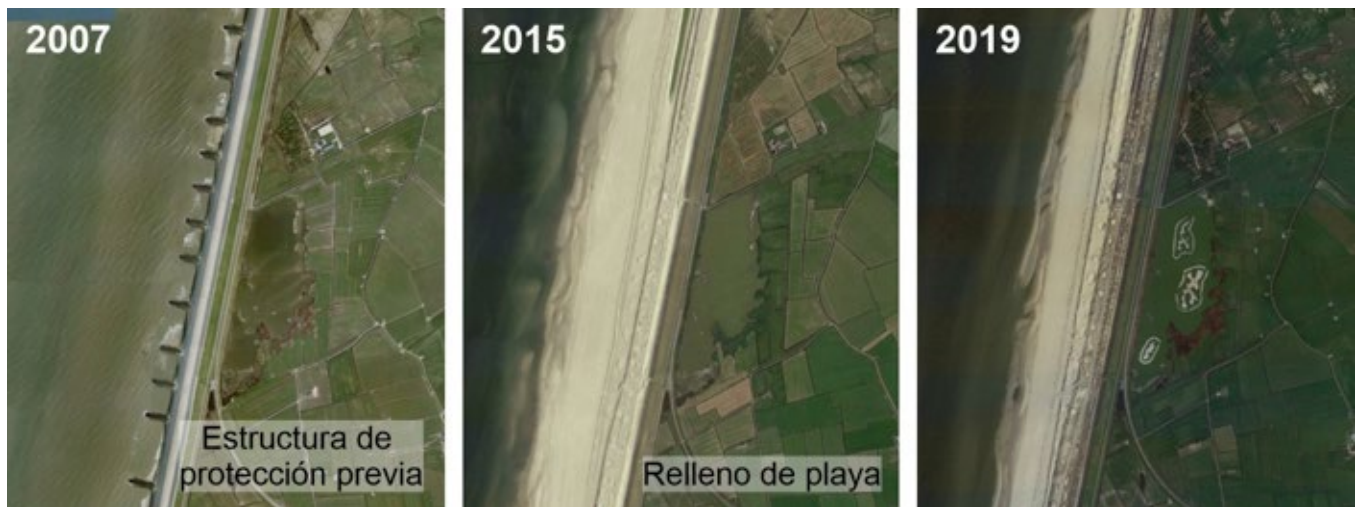
Figura 5. Dique de Hondsbossche, Países Bajos, intervenido en 2015 con un relleno de playa y construcción de dunas (imágenes modificadas de Google Earth)
