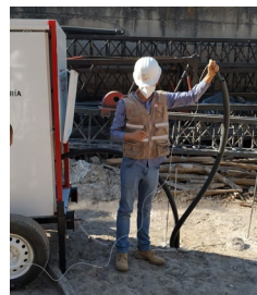
e) Medición de la temperatura media del suelo con un sensor Pt 100
