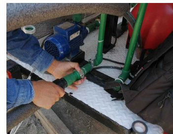
f) Conexión de las tuberías al equipo TRT-IIUNAM
