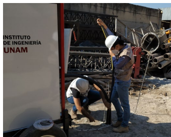
d) Corte de la tubería y colocación del aislante térmico
