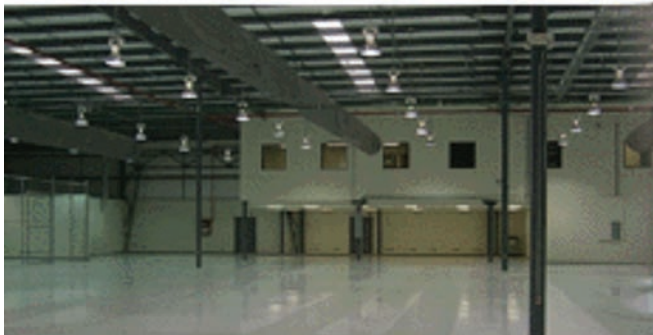
Interior de una nave industrial con pisos de altas especificaciones
