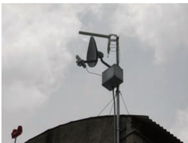
Conexión inalámbrica de la Mesa vibradora-TI
