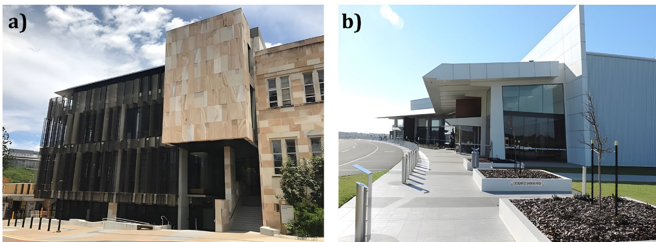
Figura 2. Ejemplos a gran escala: a) Instituto de Cambio Global y b) Aeropuerto Toowoomba Wellcamp. Fuente: Wikimedia Commons
