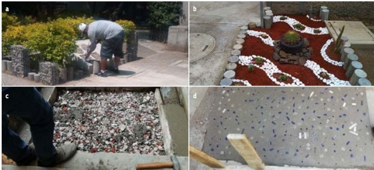
Figura 3. Otros usos de los RCD en las instalaciones del Instituto de Ingeniería, UNAM: a) gaviones y cilindros; b) jardines; c) relleno; d) banquetas
