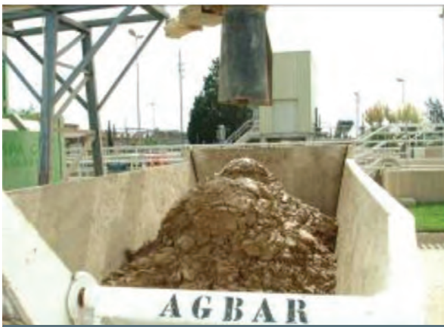
Descarga de lodos deshidratados en contenedor abierto
