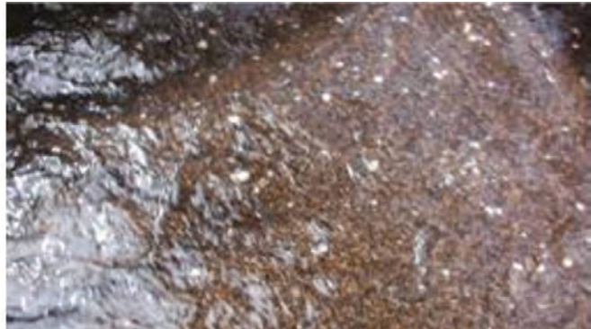
Etapa de vaciado de sedimentador donde se aprecian los lodos depositados en el fondo
