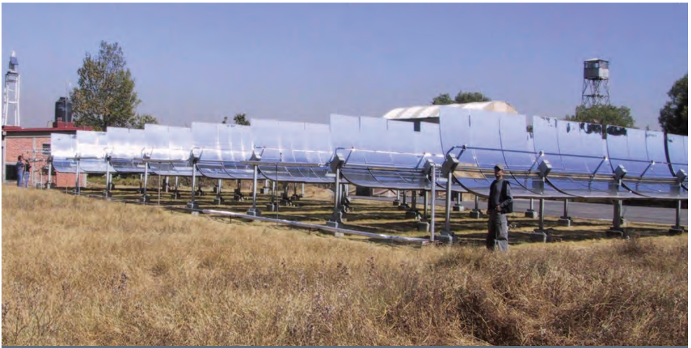
Planta solar del Instituto de Ingeniería
