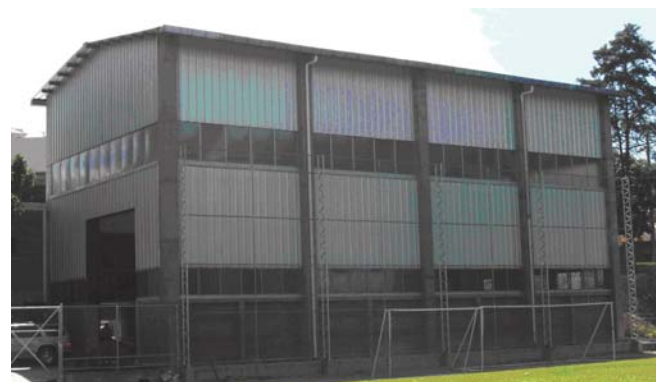
Vista general de Laboratorio de Grandes Estructuras
