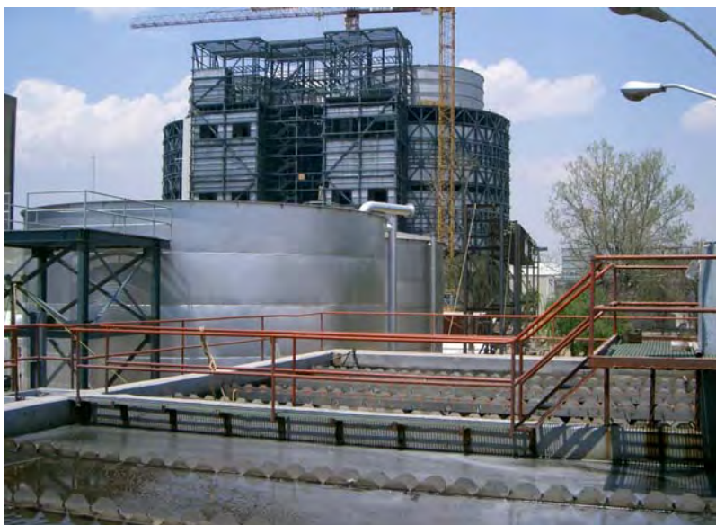
Planta de tratamiento de agua con tecnología Noyola
