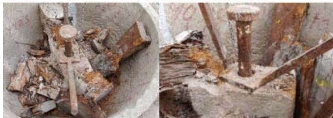
Fig VI.37 Situación en la que se encontró el interior del hemisferio inferior, en la que se aprecia la destrucción de las crucetas, la horquilla, el sillar de piedra, el extremo superior del perno incluida su cabeza y la caja del tiempo
