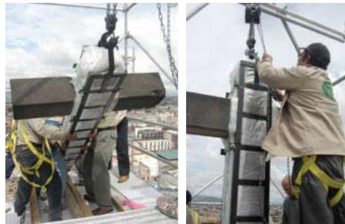
Fig VI.35 Confinamiento y desmonte de la cruz
