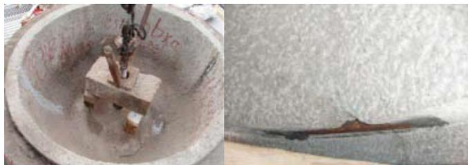
Fig VI.38 A la izquierda, vista inferior del hemisferio inferior, donde pueden observarse la horquilla, el sillar de piedra apoyado temporalmente sobre dos piezas de madera, la horquilla, el extremo superior del perno, incluida su cabeza, así como inscripciones de color rojo. A la derecha está la parte de intradós del hemisferio superior, y puede observarse la grapa instalada para reforzar la pieza fracturada de piedra
