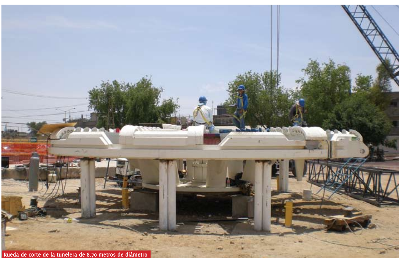
Rueda de corte de la tunelera de 8.70 metros de diámetro
