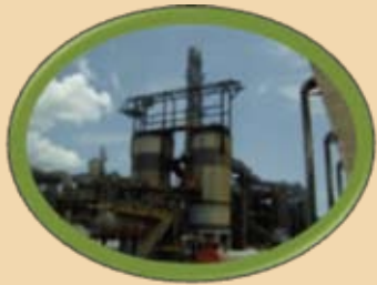
Hornos de producción de escoria como subproducto de la fundición de cobre
