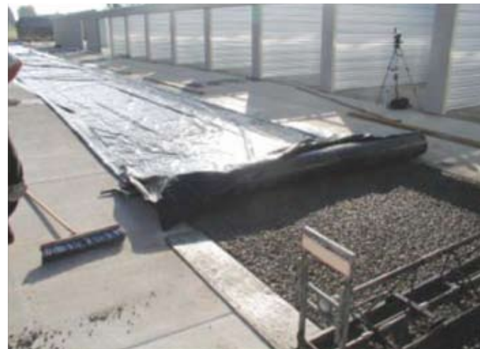
Material de polietileno utilizado para cubrir la superficie expuesta del concreto permeable (Tennis et al., 2004).
