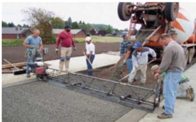
Colocación del concreto permeable por medio de un camión mezclador con descarga por atrás (Tennis et al. , 2004)
