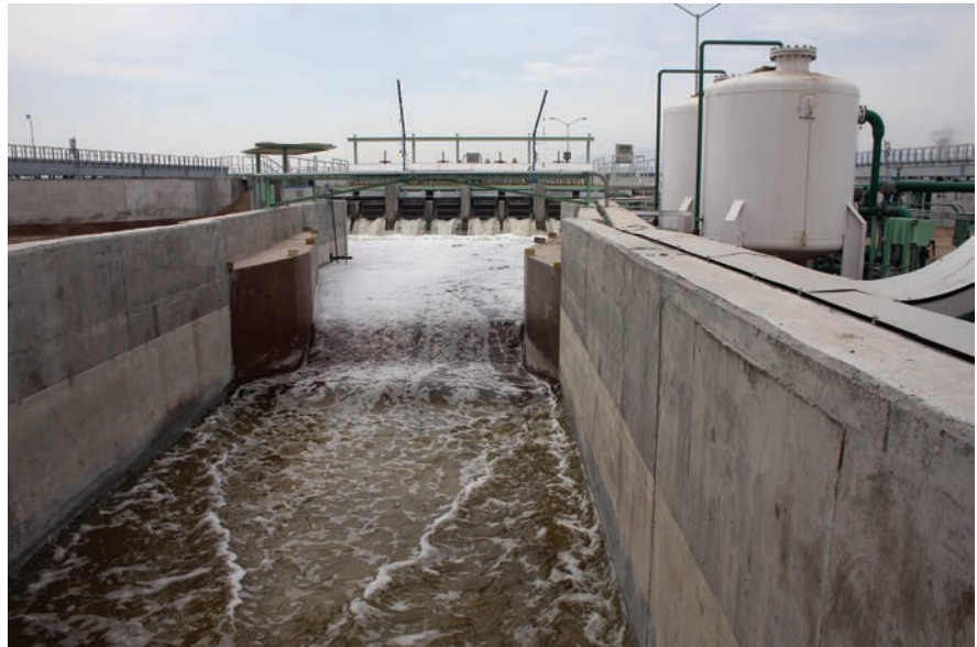
Planta de tratamiento de aguas residuales
