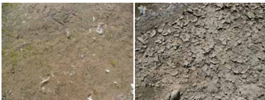
Formación de costra de colmatación
