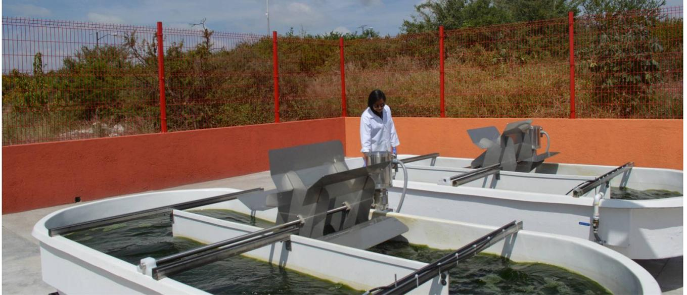
Figura 1. Reactores piloto de alta tasa ( $1\text{m}^3$ ) operados con el sistema microalga-bacteria instalados en el exterior de la UAJ
