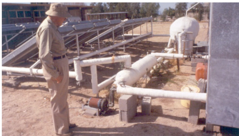
Figura 4. Destilador solar con calentamiento indirecto y recuperación de calor en etapas múltiples
