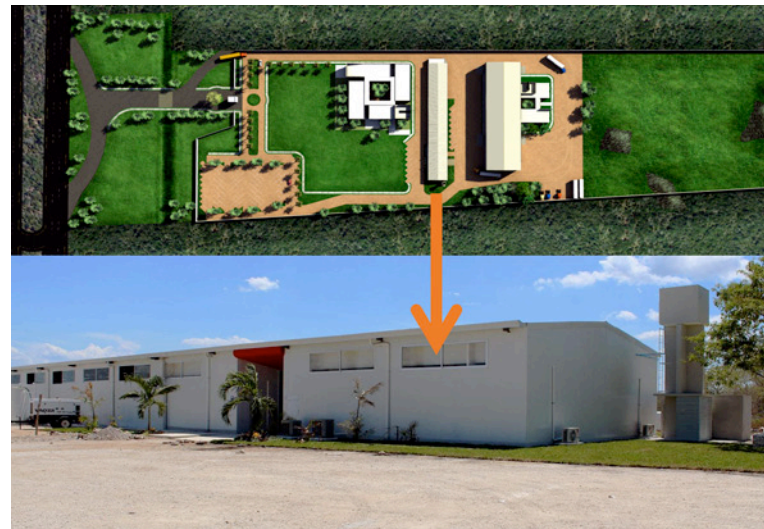
Figura 1. Ubicación y vista general del Centro de Investigación de Crudo Extrapesado y Recuperación Mejorada (CICERM) en Mérida, Yucatán
