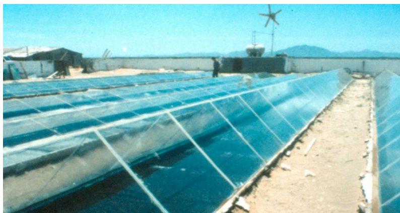
Figura 3. Destilador solar de gran dimensión para abasto de una comunidad rural (en Puerto Chale, Baja California Sur)
