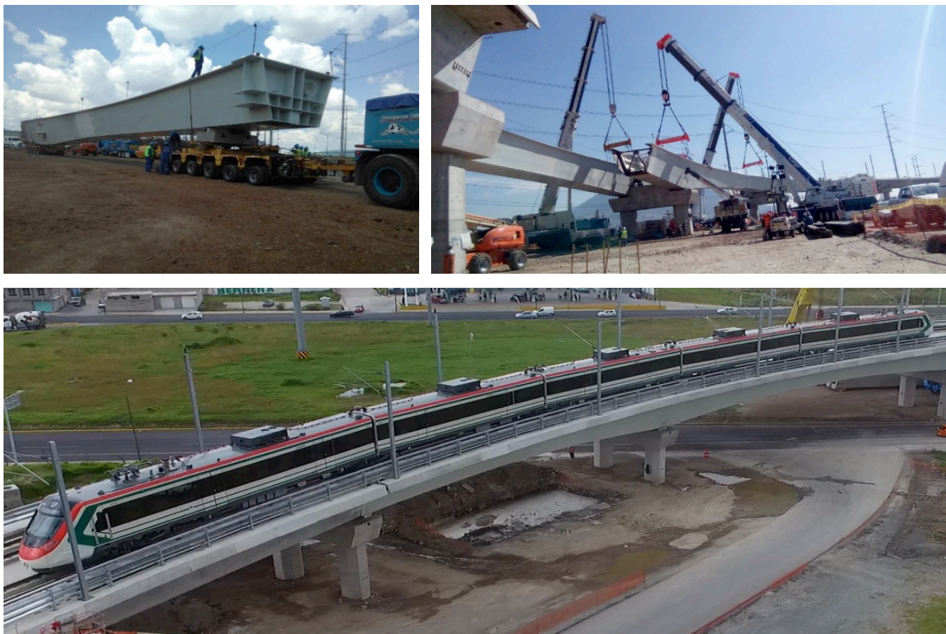
Figura 2. Viaducto 6, Tren Interurbano México-Toluca
