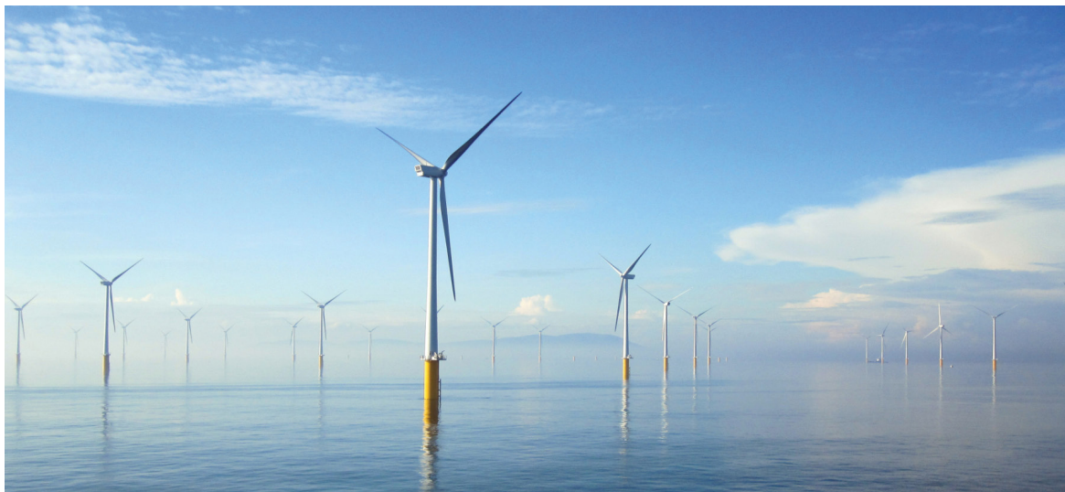
Figura 3. Parque eólico London Array, con una potencia instalada de 630 MW (fotografía tomada de http://www.londonarray.com )
