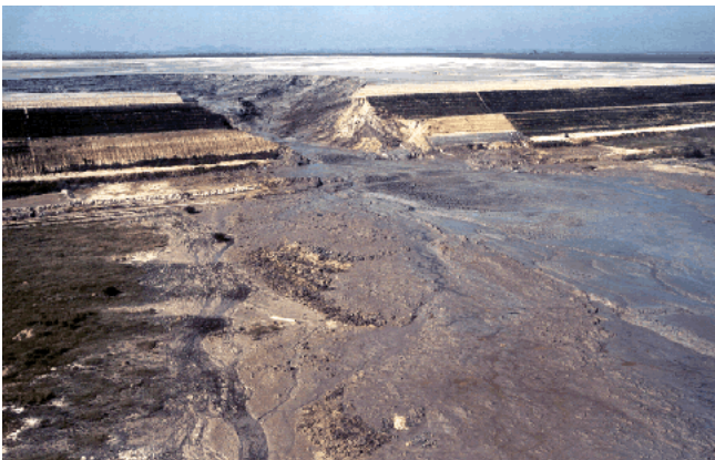
Figura 5. Toma aérea falla de Merriespruit
