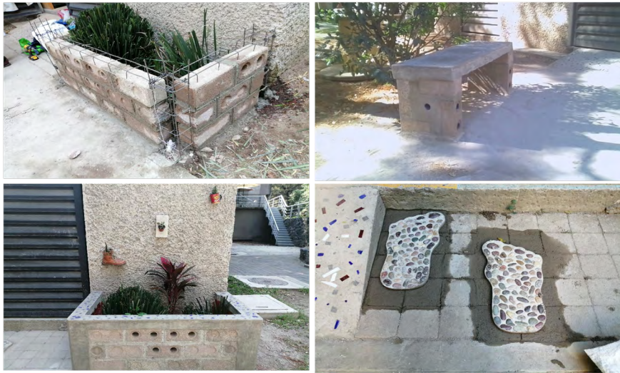
Figura 4. Mobiliario Urbano fabricado con agregados reciclados
