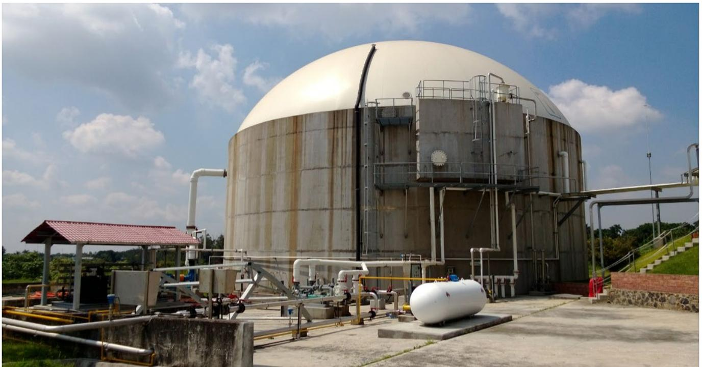
Figura 2. Digestor anaerobio de la planta de tratamiento de agua residual, Acapatzingo, Morelos
