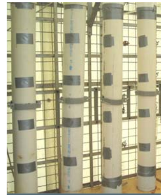
Fig 1 Imagen del grupo de columnas de biofiltración en planta piloto para tratamiento de H 2 S.
