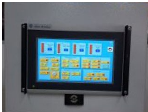
Figura 3. a) Pantalla de 7 pulgadas en el cuarto de control del muro de reacción del CENAPRED. b) Ampliación de la Pantalla de 7 pulgadas, conectada al PLC Allen Bradley
