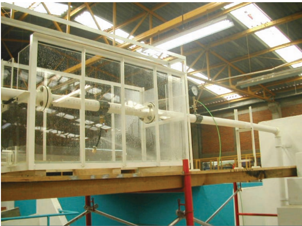
Instalación experimental para el estudio de fugas en redes de agua potable
