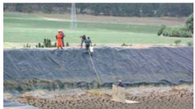
Prueba de tracción de la balsa para el muestreo de lodos donde hay agua acumulada
