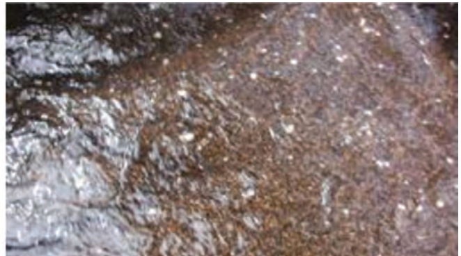
Etapa de vaciado de sedimentador donde se aprecian los lodos depositados en el fondo
