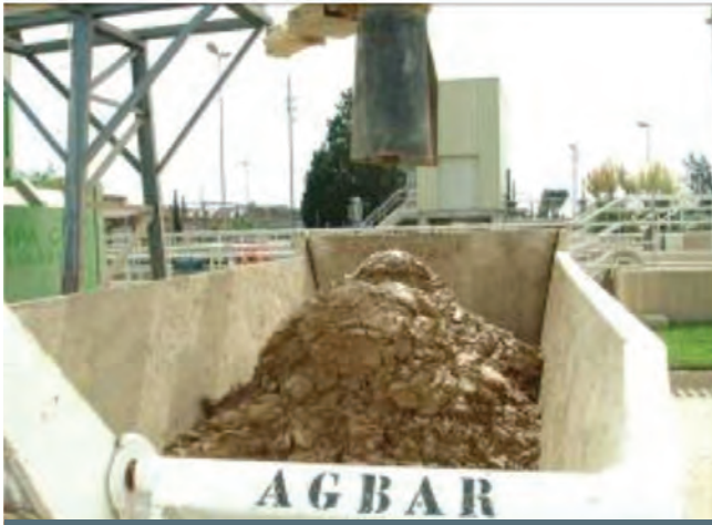
Descarga de lodos deshidratados en contenedor abierto
