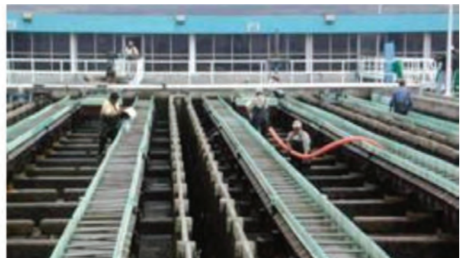
Lavado hidráulico (mangueras y botes) del sedimentador
