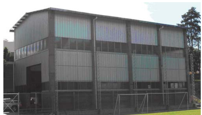
Vista general de Laboratorio de Grandes Estructuras
