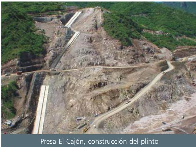
Presa El Cajón, construcción del plinto
