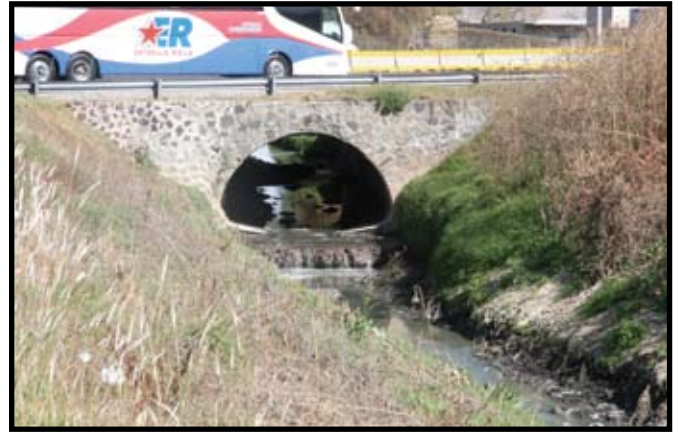
Fig 4. Alcantarilla de cruce con la autopista México - Puebla
