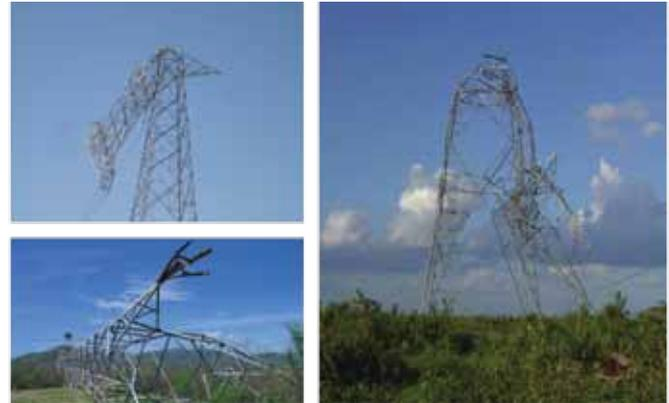
Fig. 1. Daño en el soporte de las torres de una línea de transmisión de la CFE
