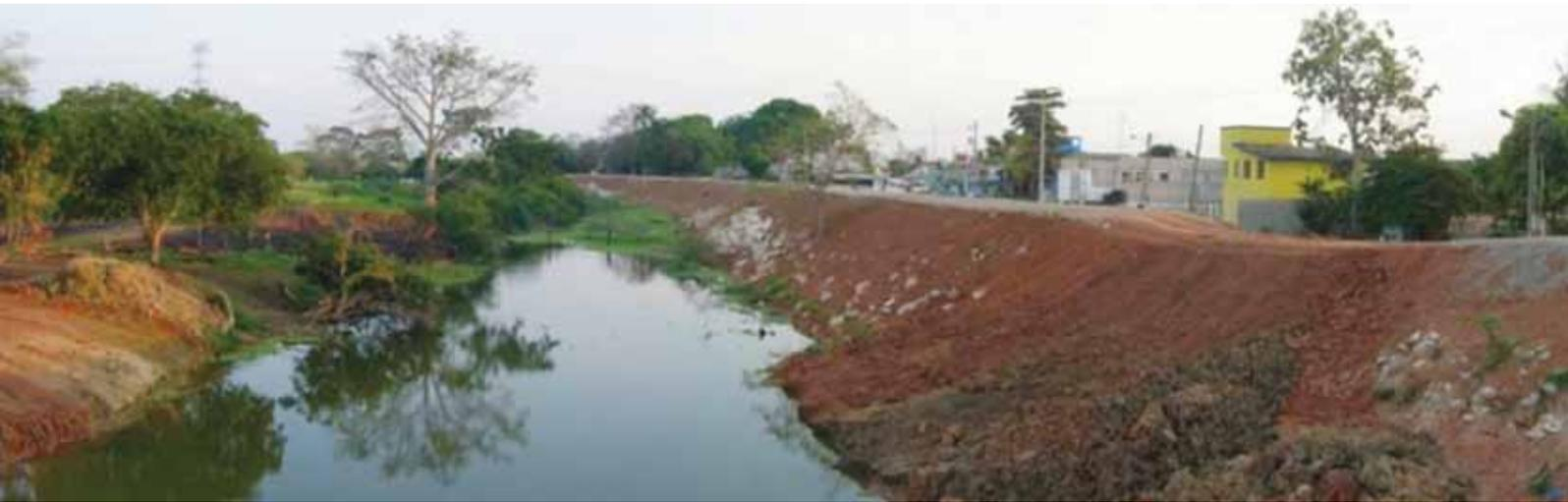
A partir de los resultados obtenidos de la modelación numérica realizada en esta investigación, se proponen soluciones para incrementar la estabilidad de los bordos que están sometidos al fenómeno de vaciado rápido. Y es que cuando un terraplén experimenta variaciones del nivel de agua, se modifican las condiciones de equilibrio dentro y fuera de la masa térrea, lo que afecta su estabilidad.
