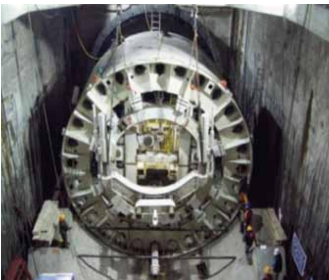
Figura 5. Proceso de ensamble de la tuneladora
