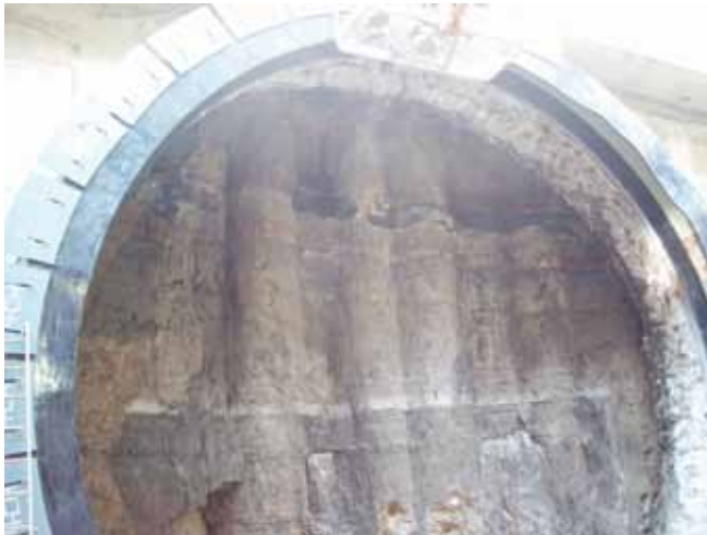
Figura 6. Vista del terreno mejorado
